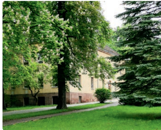
Schulgebäude Dresdner Straße, Haus 14
